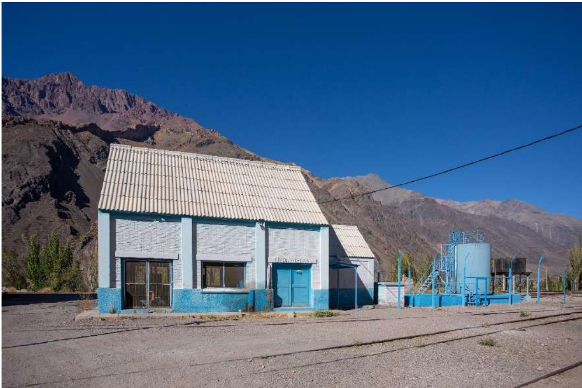
Figura 74. Central térmica Polvaredas.
