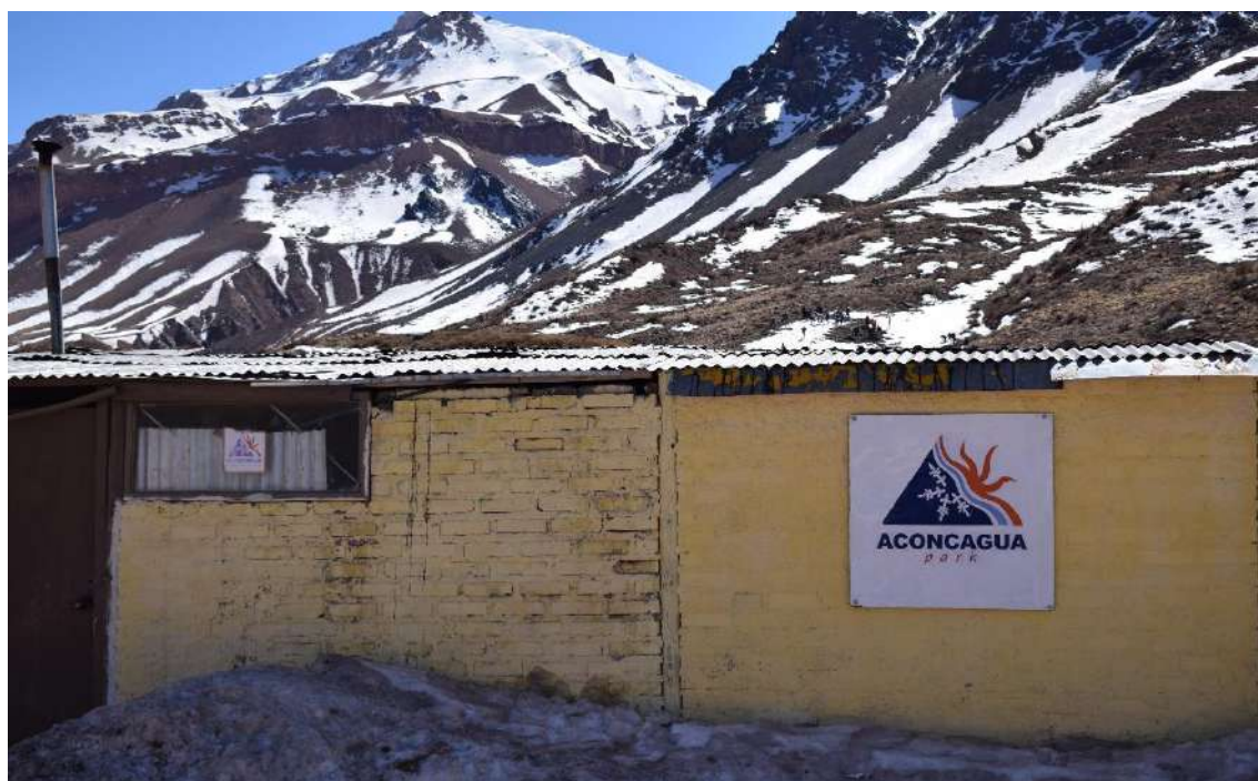
Figura 140. Instalaciones Parque de nieve Aconcagua Park.
