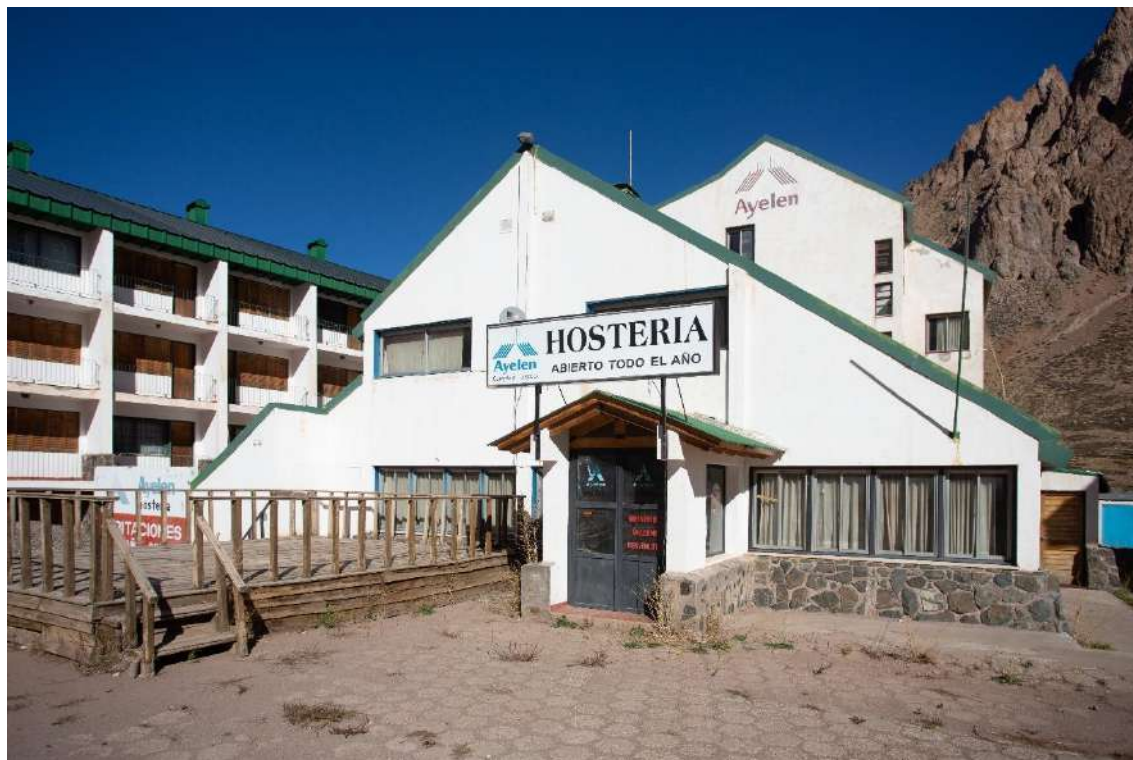
Figura 125. Infraestructura edilicia de Penitentes. Hostería Ayelén.
