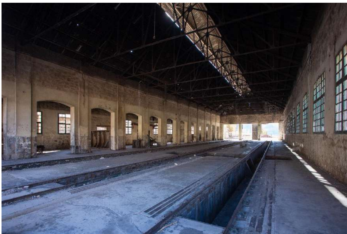
Figura 85. Taller de reparaciones. Estación Polvaredas.
