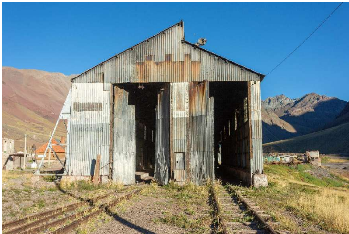
Figura 170. Galpón ferroviario Tren Trasandino. Localidad de Las Cuevas.
