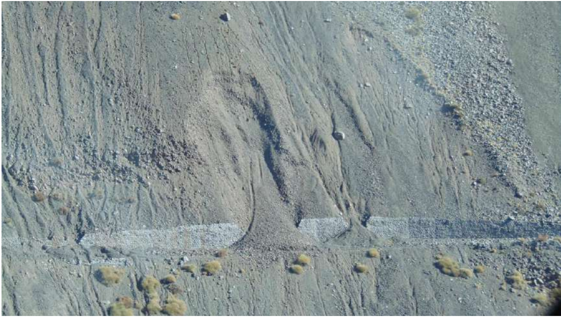
Figura 248. Procesos de remoción en masa sobre tramo de la Vía Turística.
