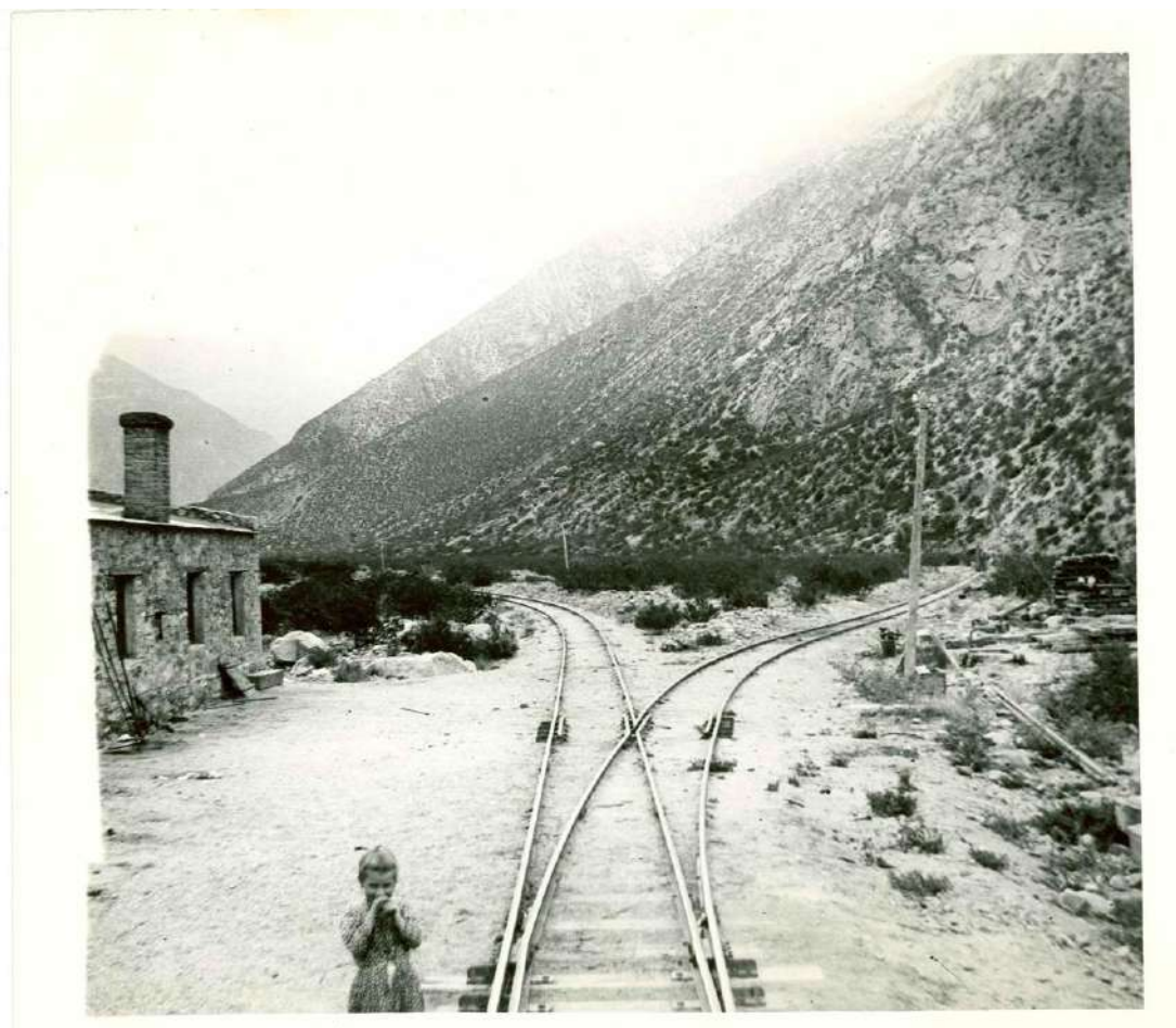
Figura 199. Estación del Tren Trasandino, Puente de Inca
