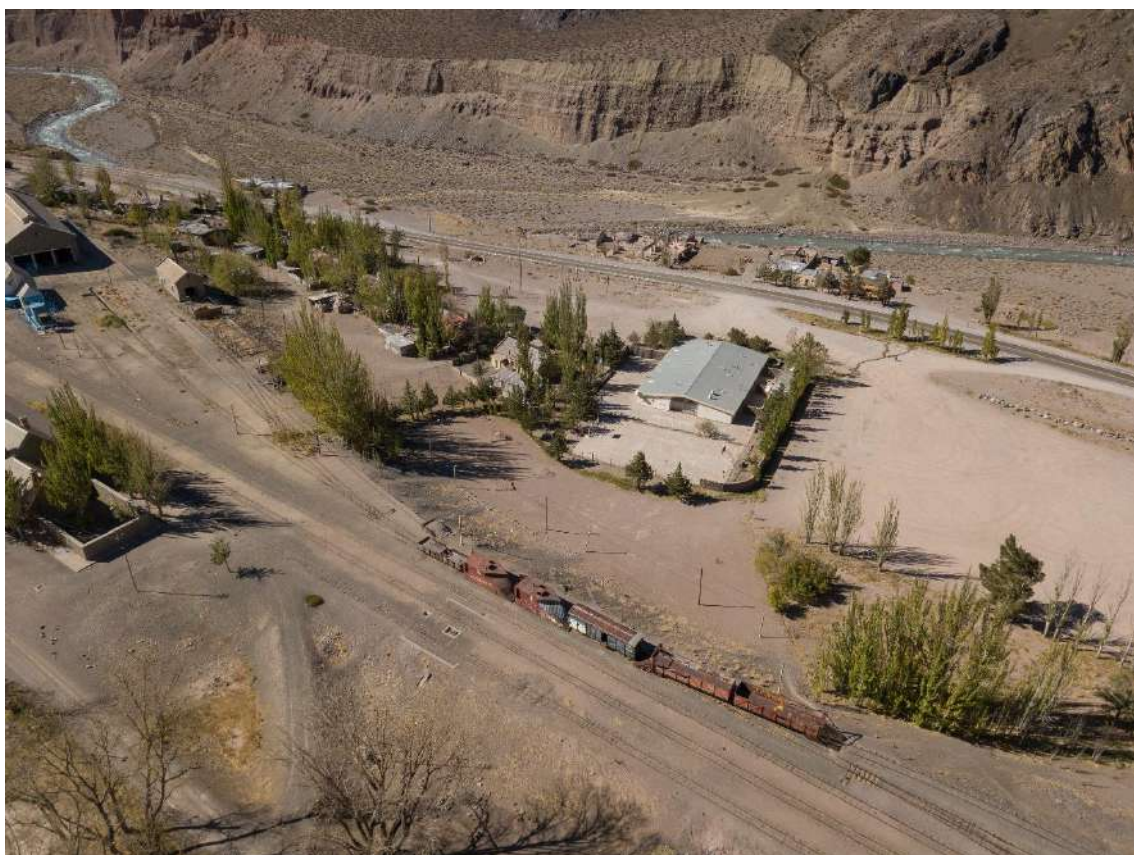
Figura 87 Vista área de la localidad de Polvaredas. Zona de escuela y playón de estacionamiento.
