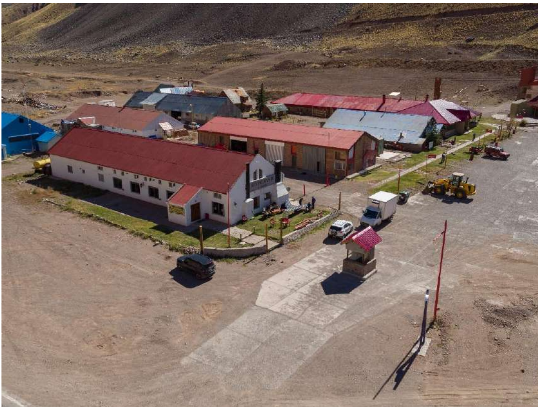
Figura 124. Infraestructura edilicia de Penitentes.
