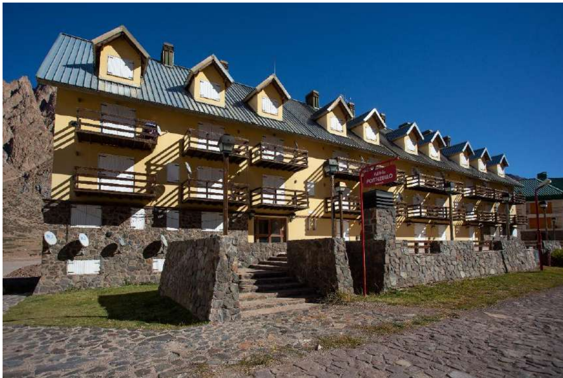
Figura 123. Infraestructura edilicia de Penitentes.
