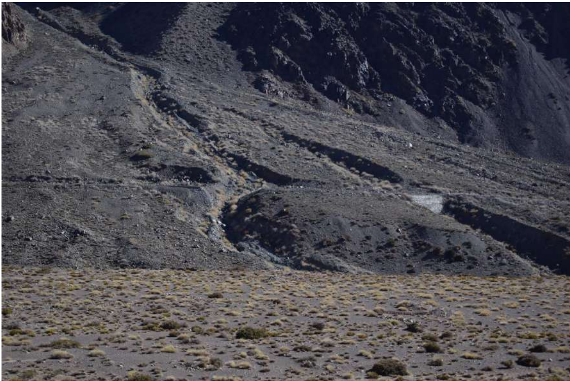
Figura 252. Procesos de remoción en masa sobre tramo de la Vía Turística.
