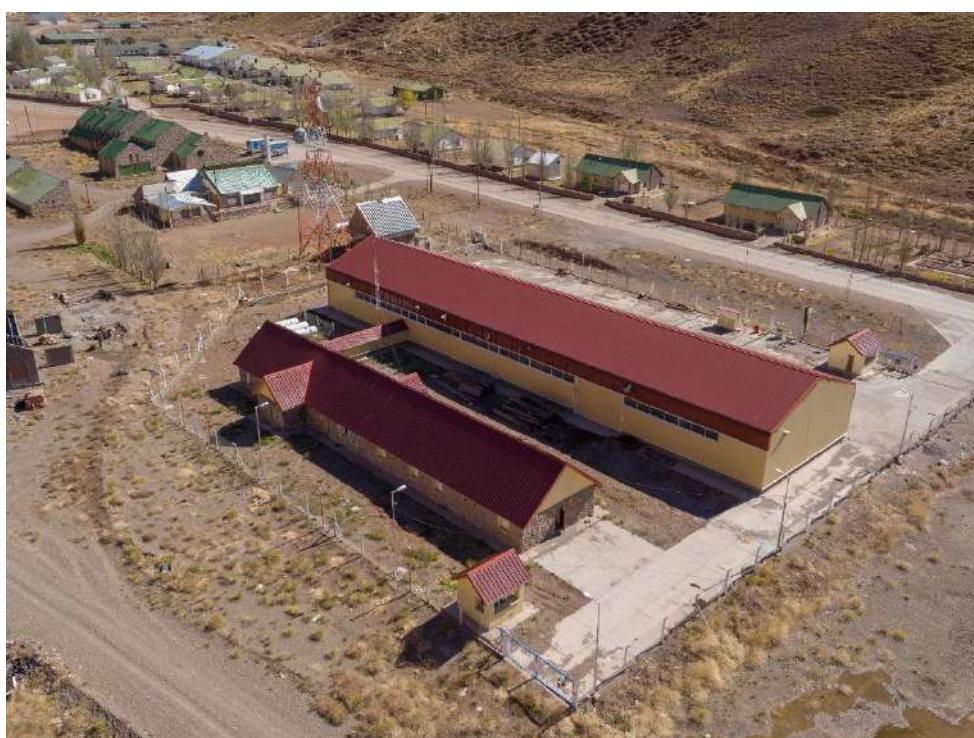
Figura 154. Establecimiento de Vialidad Nacional. Localidad de Puente del Inca.
