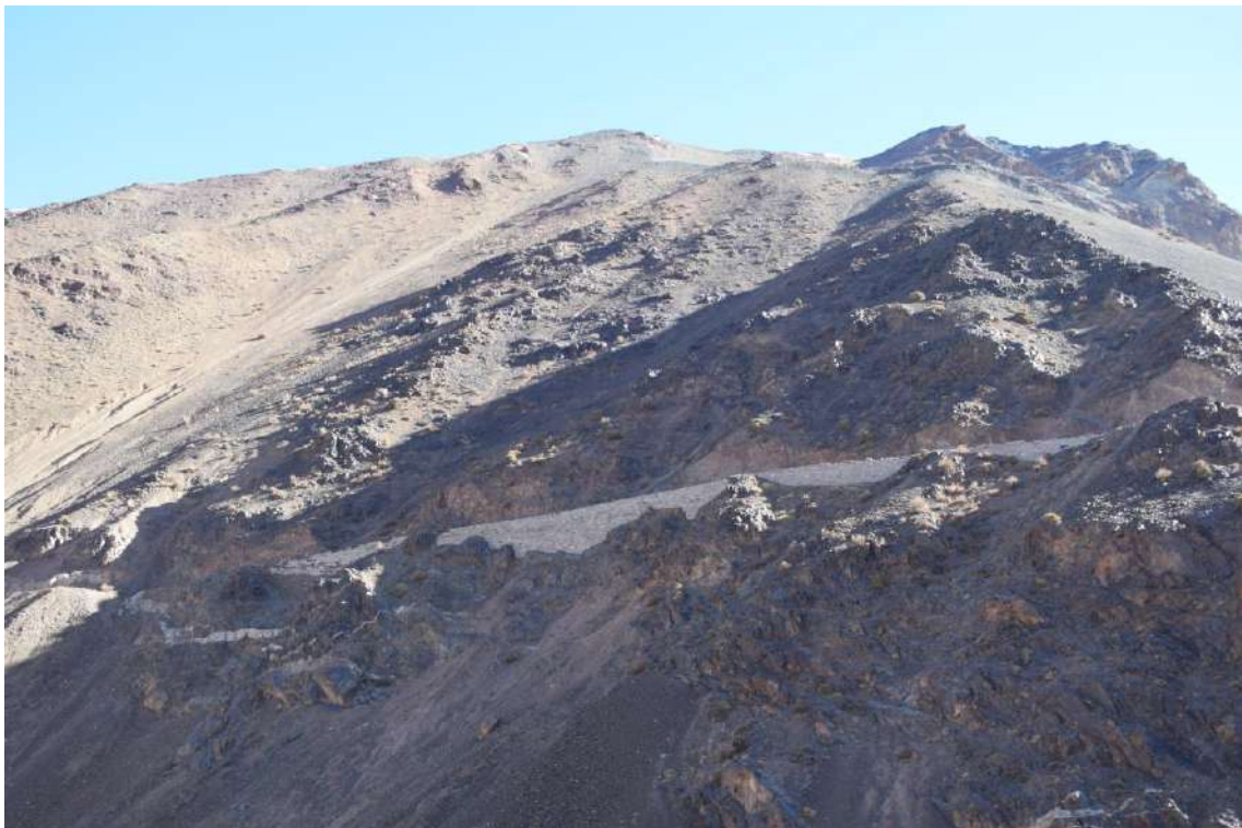
Figura 249. Muros de contención sobre la antigua ruta a Chile.
