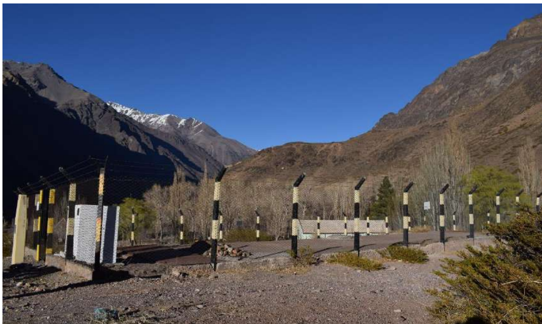
Figura 75. Planta potabilizadora Polvaredas.
