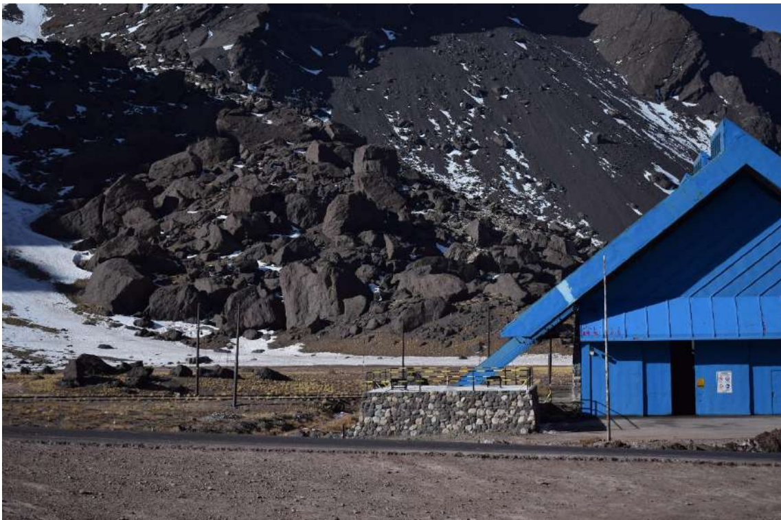
Figura 25. Deslizamientos rocosos, quebrada del Hombre Cojo, ladera N del Co. Tolosa.
