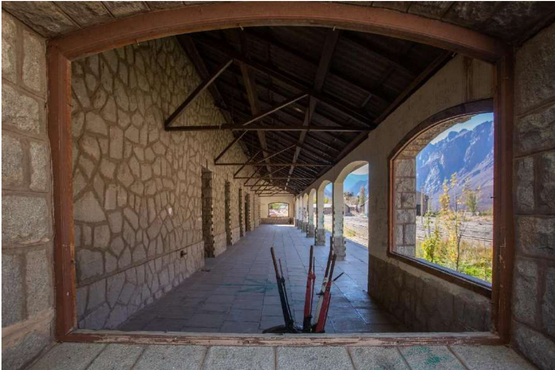
Figura 83. Andén de la Estación del Ferrocarril Trasandino. Estación Polvaredas.
